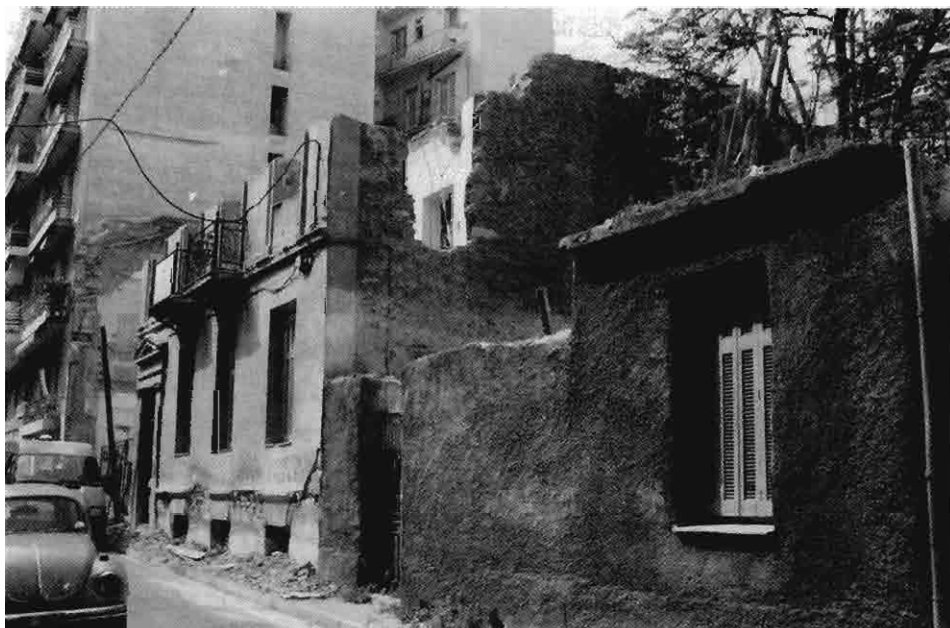
Jo osittain purettu alkuperäinen Zitrou 16:n rakennus ja Zitrou 14:n vaatimattoman talon pääty.
