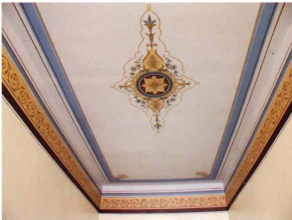
Vanhan mallin mukaan tehty kattomaalaus instituuttirakennuksen vestibyyliässä.
